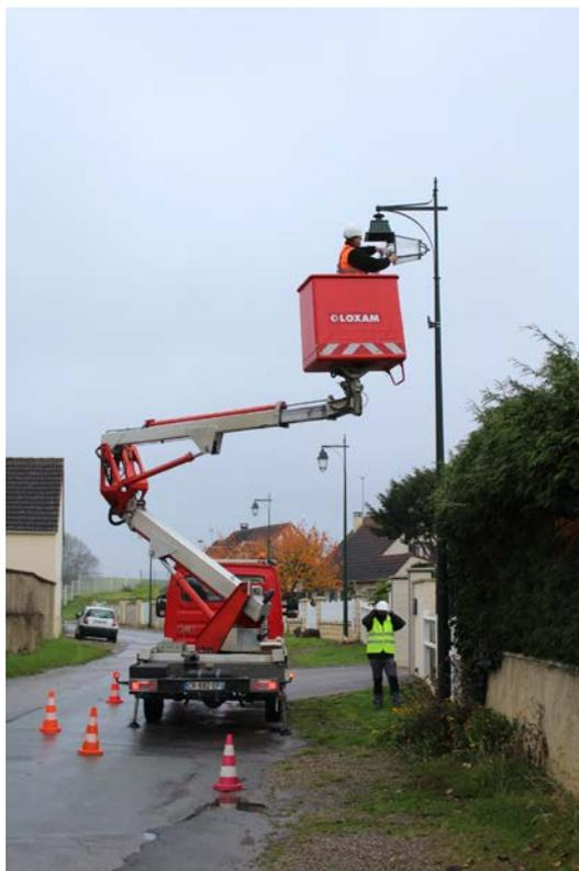
L'opération a consisté à changer nos vieilles ampoules à vapeur de sodium de 100 W et 150 W (+20 W de Ballast) par des ampoules LED de 40 W ou 60 W soit une division par 2,8 de nos factures EDF pour l'éclairage public.
